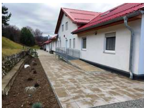
Der Neubau im Dezember 2025
